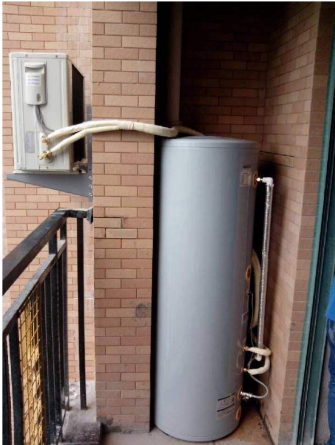
▲空气能热水器的外机和水箱
