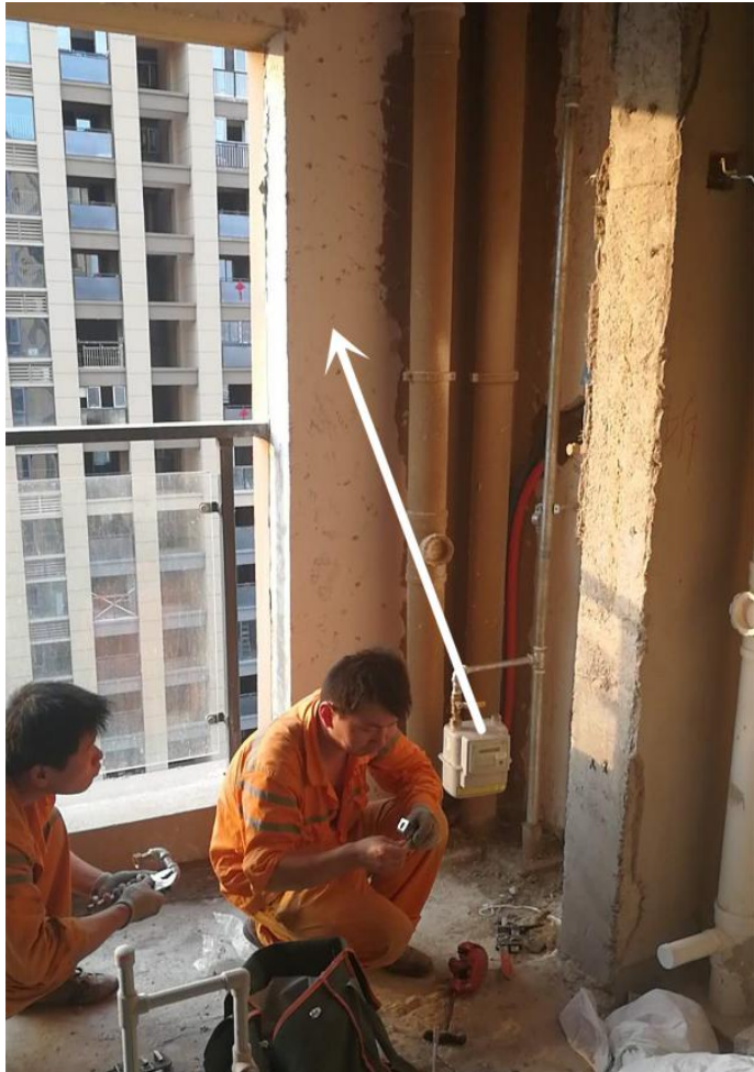
▲将燃气表移到合适的位置
