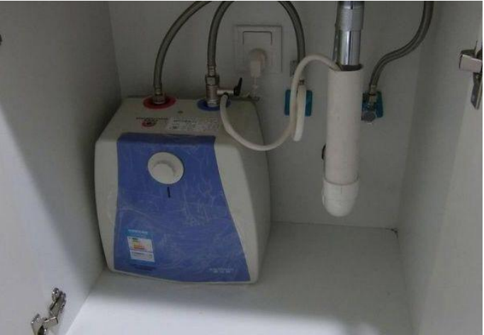
▲找不到浴室柜里带小厨宝的图了，用橱柜带小厨宝的图凑合一下。提醒浴室柜底下的空间通常比较小，有的可能放不下小厨宝。
